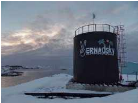
Новий резервуар РВС-200 для пального з сучасною візитівкою станції «Академік Вернадський». 2016 р. (фото І. Парнікози)
