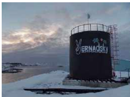
Новий резервуар РВС-200 для пального з сучасною візитівкою станції «Академік Вернадський». 2016 р. (фото І. Парнікози)
